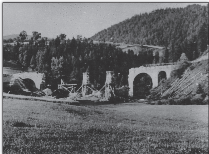
Železniški viadukt v Doliču, po partizanski diverzantski akciji 18. junija 1944. leta
