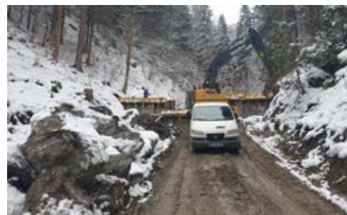
Izgradnja kamnitih pregrad
