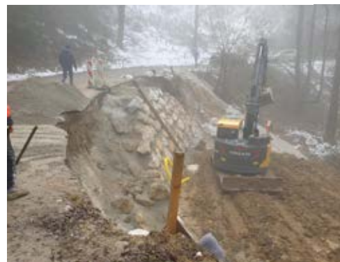
Izvedba kamnite zložbe – plaz Pik
