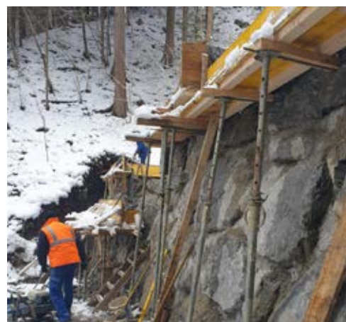
Izvedba venca na kamniti pregradi
