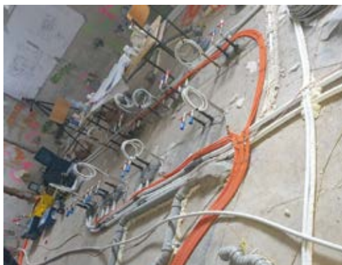
Priprava instalacij za termoblok v kuhinji
