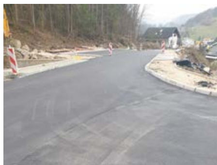
Asfaltiranje na območju novega mostu na Pohorski cesti
