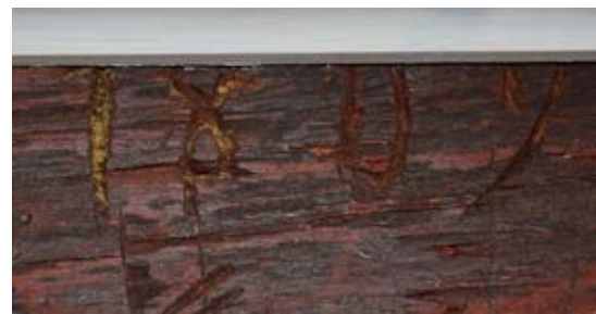
Letnica 1809 na stropnem tramu na Pavrovem je delno prekrita z novejšo stropno oblogo, 20. 2. 2020. Foto M. Jež
